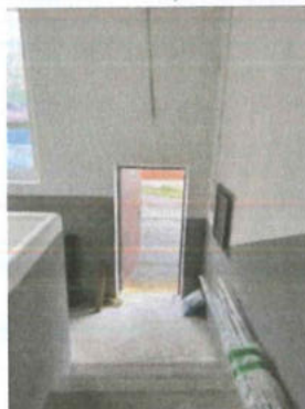
I.NP. - vstupní hala, pohled na hl. vstup
